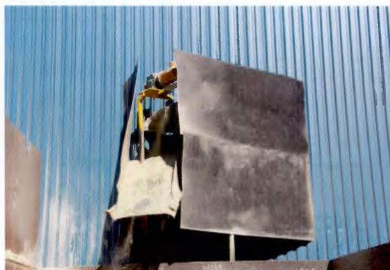
Figure 2.28 Particules expulsées à l'extérieur par des dépoussiéreurs. 2M Ressources, Saint-Jean-sur-Richelieu, 2016.
