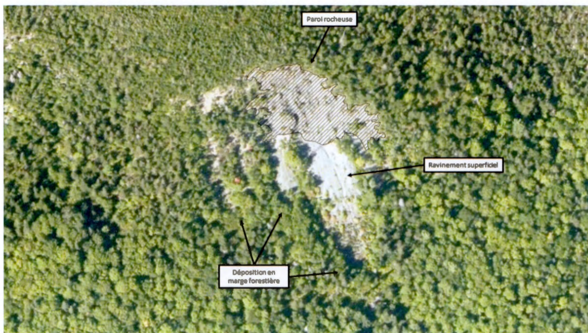
Figure 4.7: Présentation d'un talus d'éboulis principalement affecté par les chutes de pierres (site V41).
