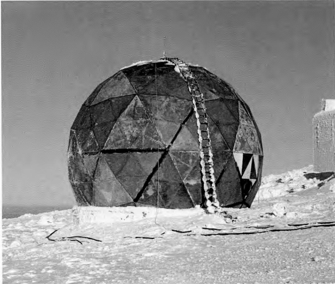
Figure 30. Prototype du premier radome rigide en 1952 par R. Buckminster Fuller et MIT Lincoln Laboratory. Source : MIT Lincoln Laboratory Lexington.
