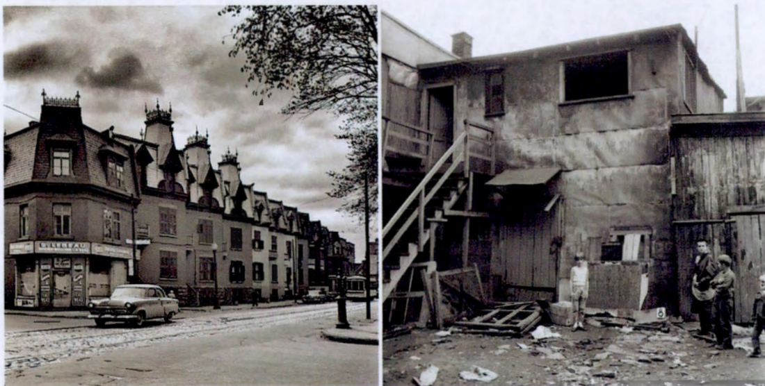
Figure 4.2 Vue arrière du secteur rasé pour la construction des habitations Jeanne-Mance c. 1950
