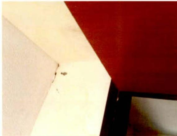
Figure 4.39 Traces de fissures et d'infiltration à l'intérieur des maisons
