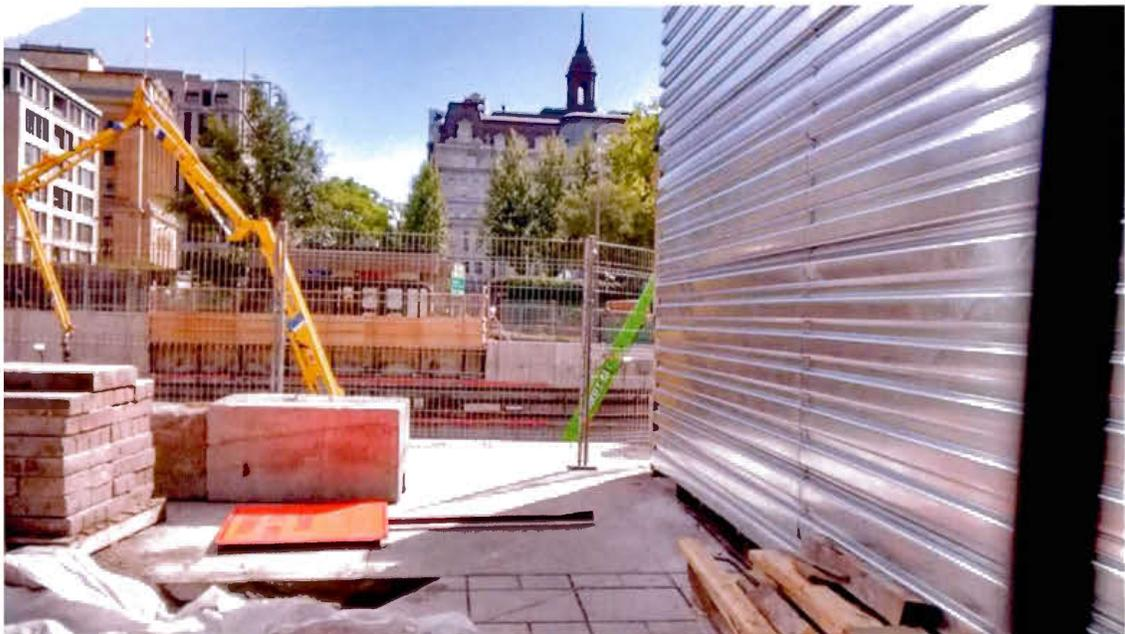
Station de métro Champ-de-Mars, rénovations 2016-2017 : protection du vitrail par des panneaux de tôle (septembre 2016)
